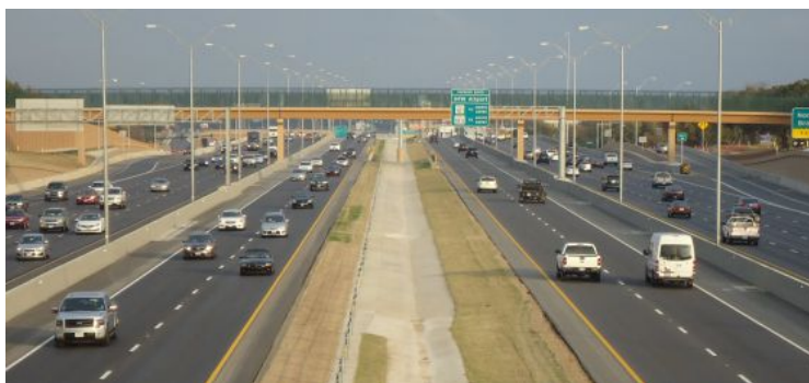
Autopista de peaje North Tarrant Express (NTE) entre Dallas y Fort Worth, construida por Ferrovial. / EL PAÍS
